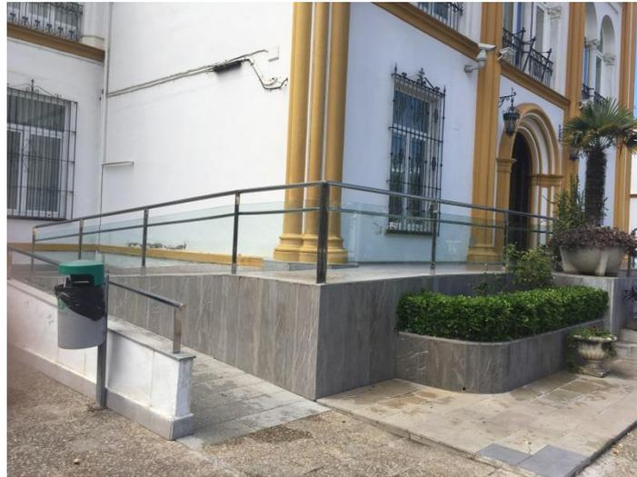
Fig. 7. Rampa de acceso para carritos de bebés y sillas de ruedas.
